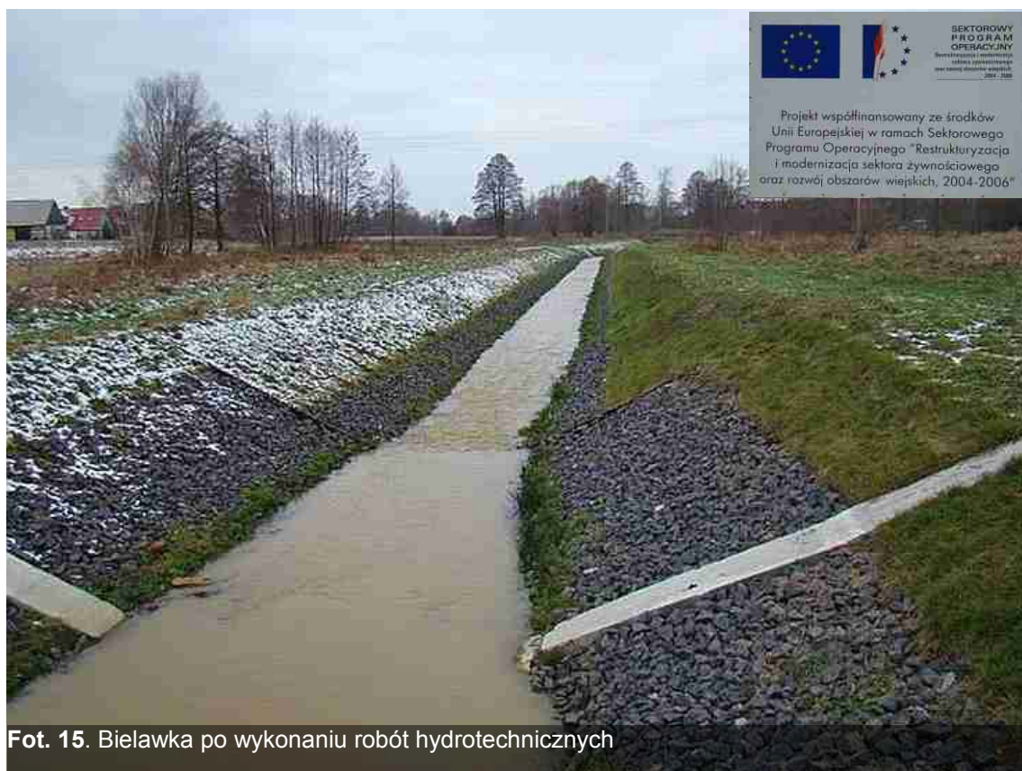
Fot. 14. Bielawka we wsi Dłużyna Górna po wykonaniu robót hydrotechnicznych
