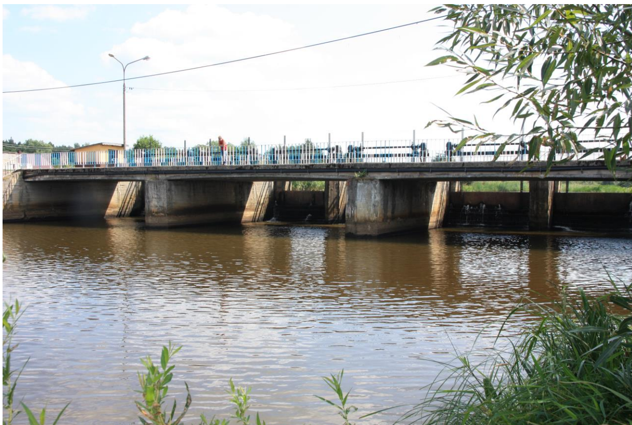
Fot. 1. Jaz w miejscowości Cieklińsko. Lipiec i sierpień 2015 r. Widoczny brak przepływu.
