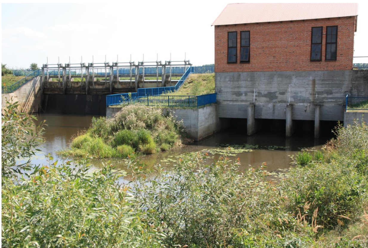
Fot. 2. MEW I w Rudzie Malenieckiej. Lipiec i sierpień 2015 r. Widoczny brak przepływu podczas piętrzenia (przepływu brak również przez turbinę). Sytuacja powtarza się tutaj przez większą część roku.
